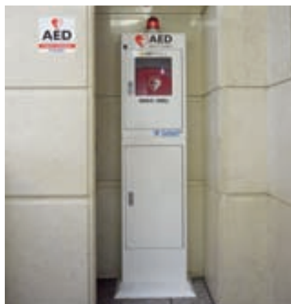
本社ビル1階共用部に設置されたAED
